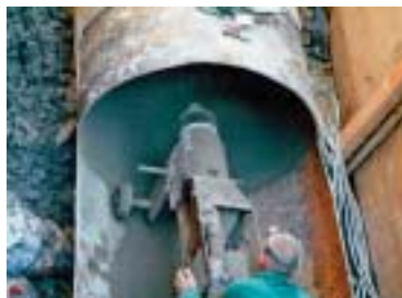
FIGURA 5 - UNA TESTA ROTANTE IN AZIONE IN UN ADDUTTORE IDRICO DN1200
