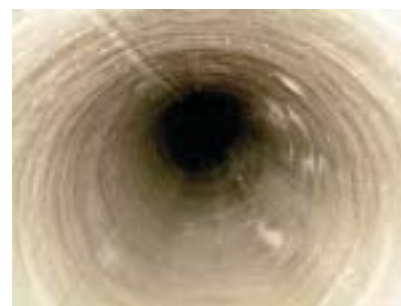
FIGURA 13 - LA TUBAZIONE DN1200 IN ACCIAIO RISANATA DA METROPOLITANA MILANESE SPA NELL'AGOSTO DEL 2007 (PER GENTILE CONCESSIONE DELLA RISANAMENTO CONDOTTE SRL)
