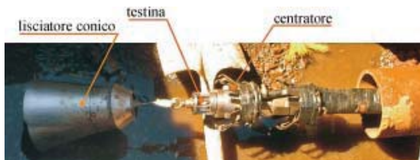
FIGURA 4 - LINING MACHINE CON LISCIATORE CONICO PER UNA TUBAZIONE DI PICCOLO DIAMETRO
